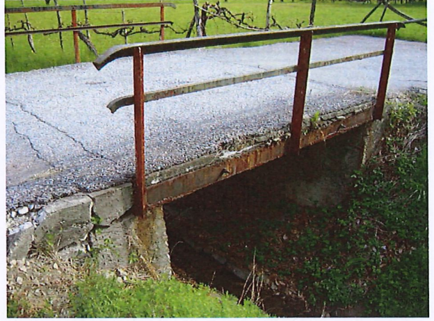
Dettaglio corrosione lato monte
