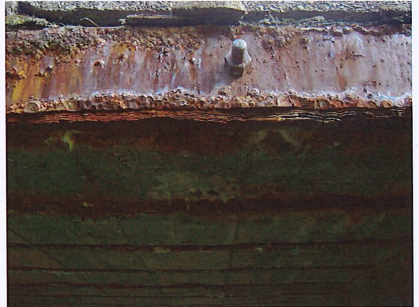
Dettaglio corrosione lato monte
