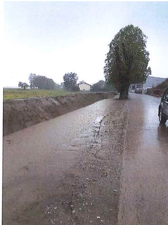
situazione con cunetta provvisoria
