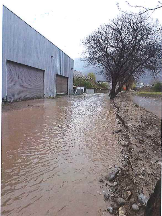
situazione prima della cunetta provvisoria
