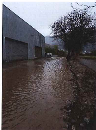
Foto 2: Tratto stradale adiacente il bacino di 30 m (foto del 04.04.2019)
