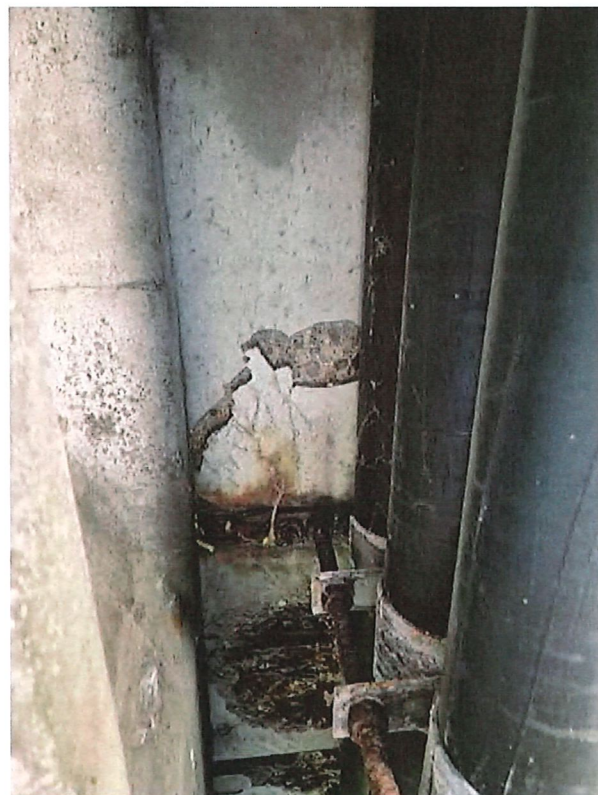
Foto 22 - Dettaglio fissaggi arrugginiti
