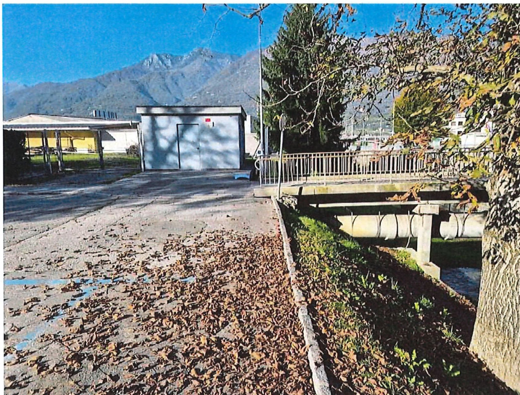
Foto 7 - Vista spalla lato Sud
