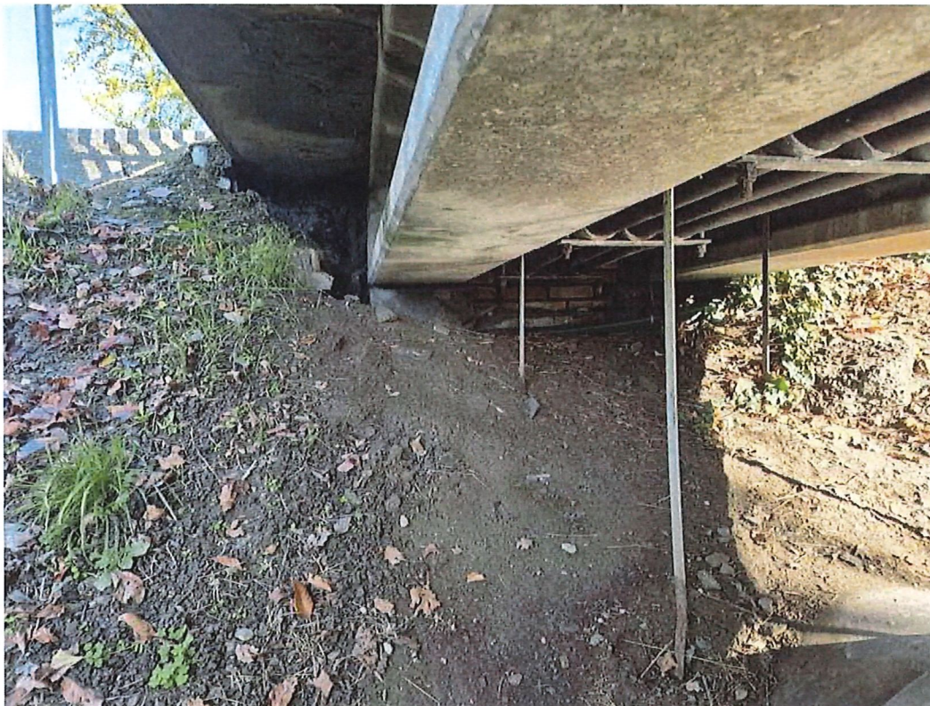
Foto 9 - Sottovista spalla lato Scuole
