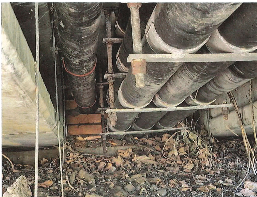
Foto 10 - Sottovista spalla Sud
