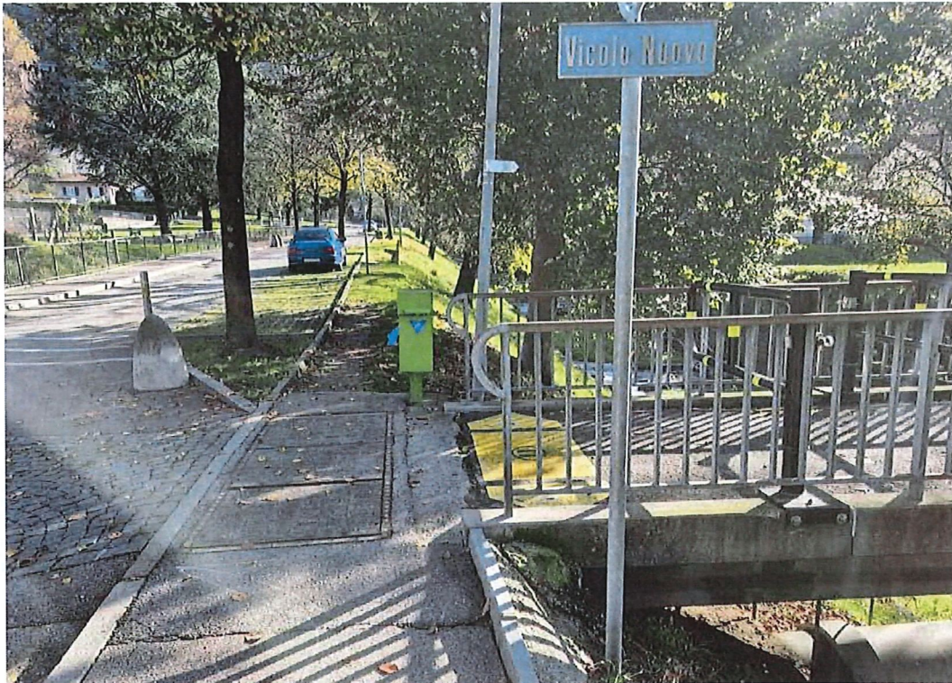
Foto 5 - Vista spalla lato Scuole
