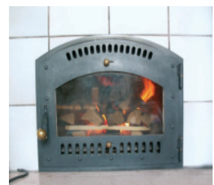
Stufa ad accumulazione (pigna)
